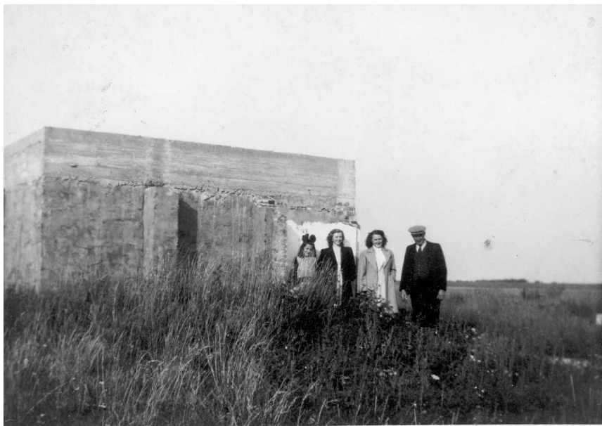
Terwijl de woningen en boerderijen op de Sluis werden afgebroken, bouwden de Duitsers verdedigingswerken in het dijktaalud langs de Sluisweg bij de tramhaven. Voor deze bunker staan v.l.n.r.: Sien Stouten, Jaantje Filius, Jaantje Souten en vader C.M. Stouten. Foto Jan Zuidweg.
