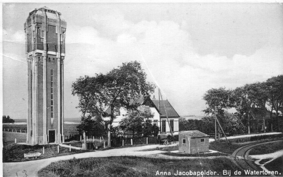
De watertoren, gebouwd in 1925, werd op 22 januari 1945 opgeblazen door Duitse commando's. De woning van de dijkbaas en het boerderijtje van C.L. Verstrate waren al in 1943 door de bezetters afgebroken.
