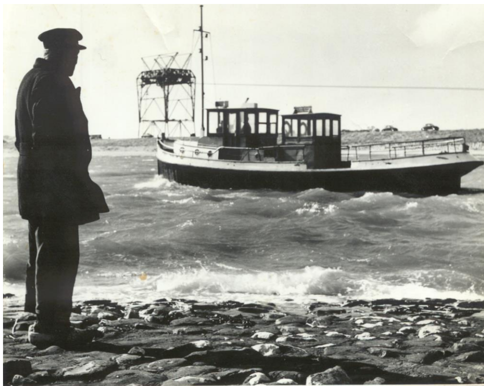
De oude schipper en veerman Volaart kijkt toe als de veerboot “Jannis” de steiger bij de hoek van Sint Jacob verlaat. Aan het roer van het schip staat Jacob Maas. Op de achtergrond is de Grevelingendam te zien, met één van de pylons van de kabelbaan.
