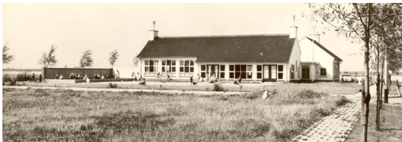
De Prinses Marijkekleuterschool aan de Wilhelminastraat. Het gebouw werd in 1953, na de watersnoodramp, geschonken door de Duitse gemeente Nordhorn. In september 1955 werd de school geopend. Het pand werd begin jaren '90 gesloopt.
