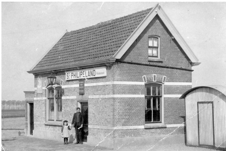
Het stationsgebouw bij de tramhalte Sint Philipsland – Slaakdam.
