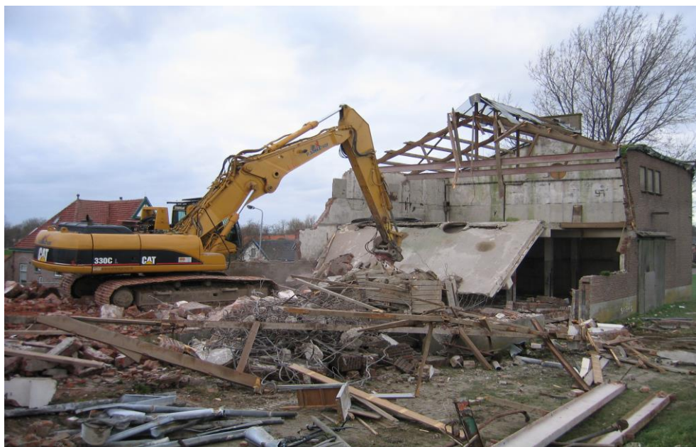
In februari 2007 werd het pakhuis van de voormalige Coöperatieve Landbouw Vereniging afgebroken. Foto: Leen van der Gouwe.
