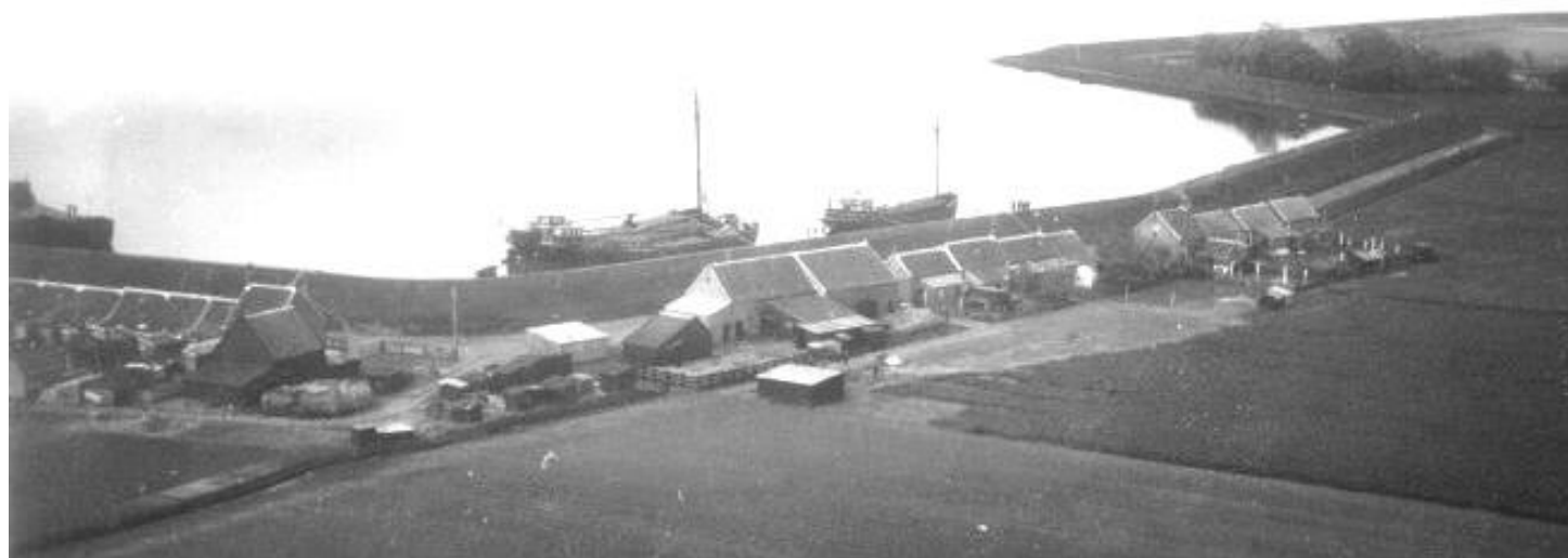
Een luchtopname van 'tussen de hoeken'. De woningen en boerderijen zijn in 1953 door het geweld van het water verloren gegaan. Deze ringdijk werd in 1682 aangelegd na een doorbraak.
