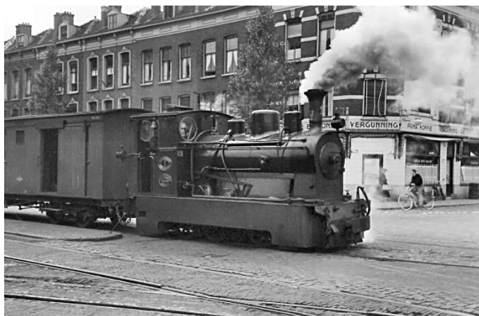
Stoomtrein in de Rotterdamse Rosestraat, eindstation.
