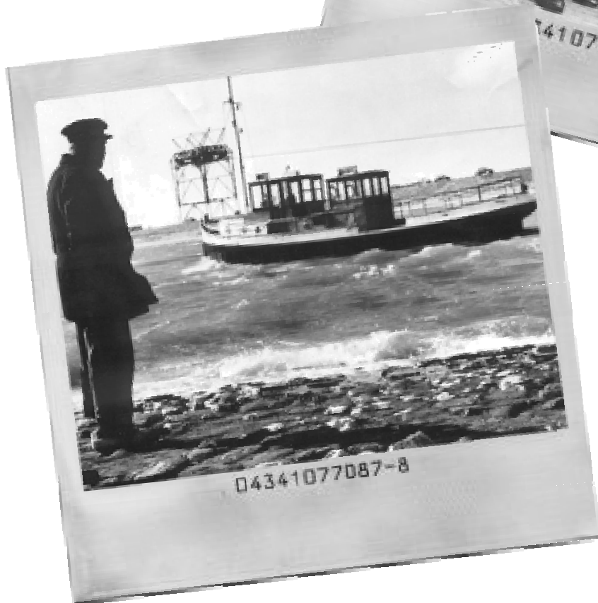
De afvaart vanaf Sint Jacob op Overflakkee Op de achtergrond de aanleg van de Grevelingendam.
