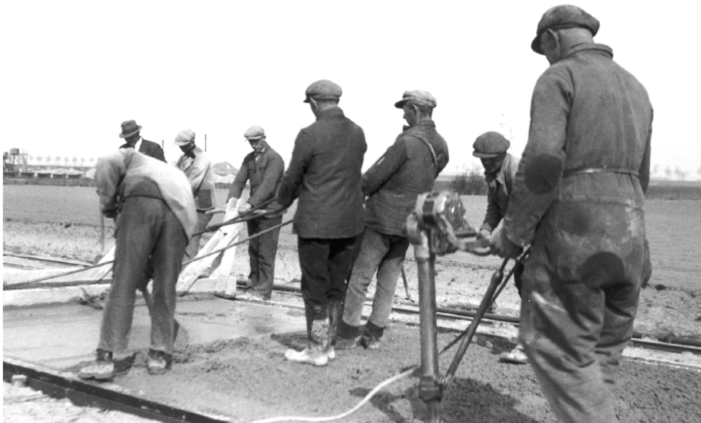
De Rijksweg vanaf de Oostdijk naar de Veerhaven in Anna Jacobapolder werd aangelegd in werkverschaffing. In vergelijking met andere werken, verdienden ze een redelijk loon. Het kon oplopen tot 18 gulden per week.
