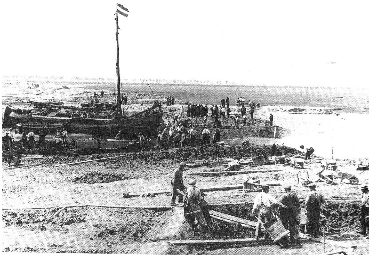
De Bruintjeskreek aan de Noordwesthoek wordt gedicht. Op de achtergrond de Boomdijk langs de Willempolder.
