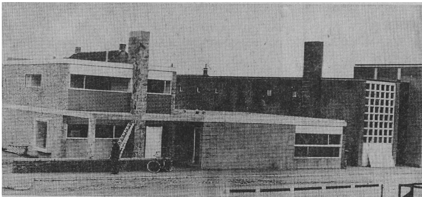
Hierboven de nieuwe Coöperatieve Raiffeisenbank net na de opening in 1965. Foto uit dagblad PZC.
