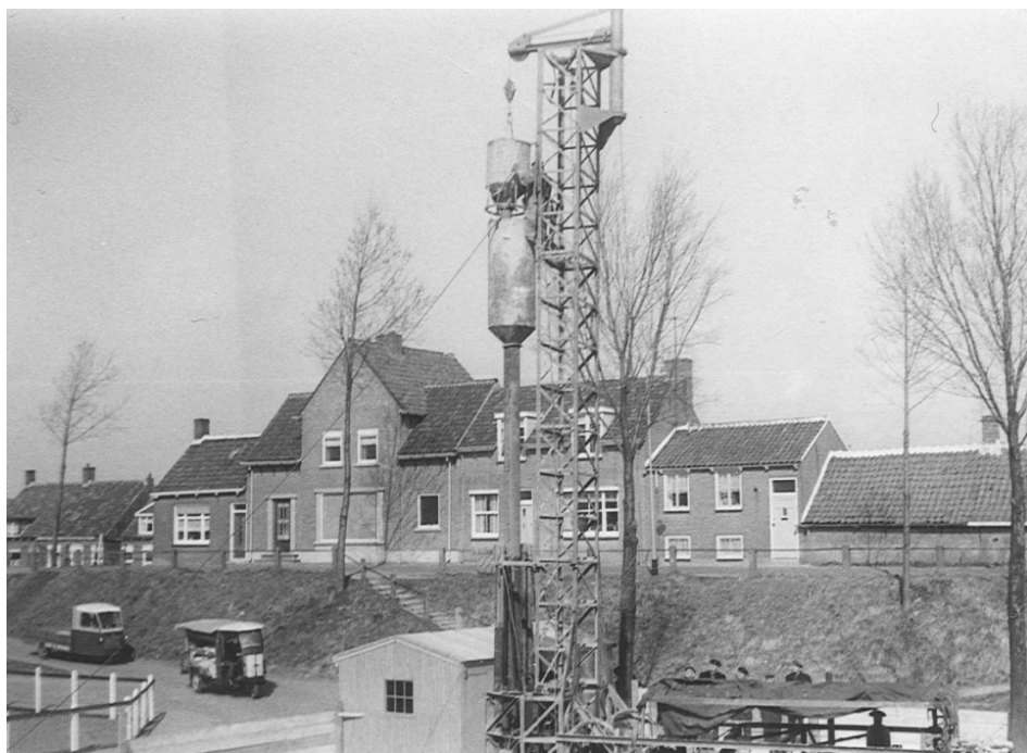
Bezig met het heien in 1964. Let op de huizen op de Oostdijk van de families Noorthoek, Everaers, Reijngoudt en Geluk. Foto: Archief gem. Tholen.
