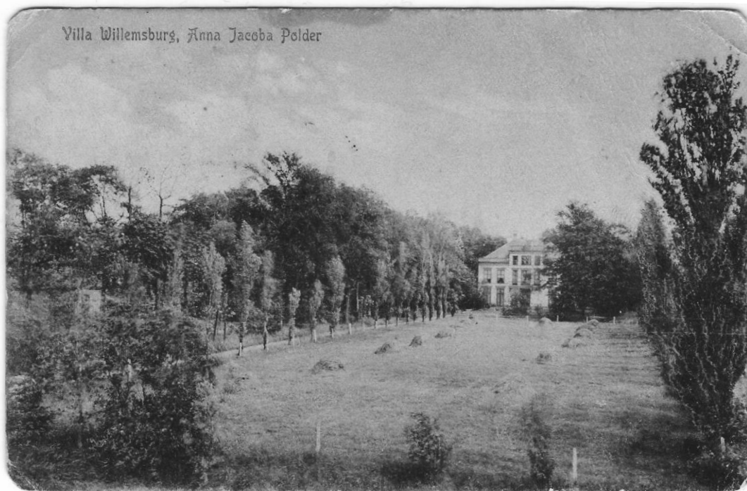
Huize Willemsburg aan de Sluisweg bij Anna Jacobapolder. De villa was de woning van Willem Frederik del Campo, genaamd Camp. Hij is hier op 10 augustus 1879 op 78-jarige leeftijd overleden. In 1918 is de woning afgebroken vanwege de vervallen staat waar het in verkeerde.
