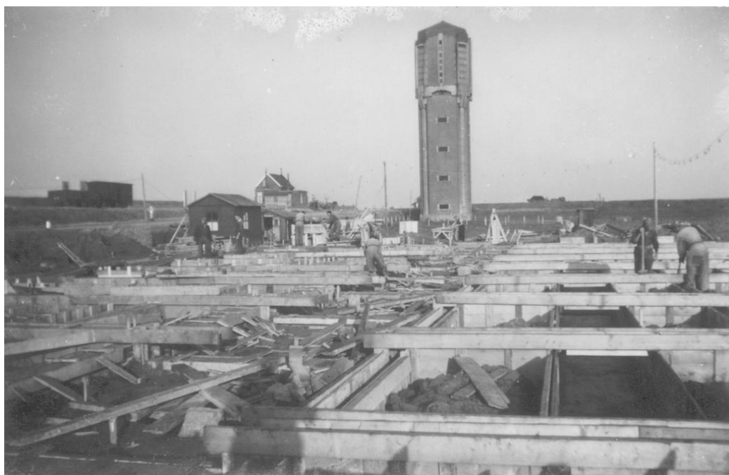
De bouw van het koelhuis aan de huidige Industrieweg in Sint Philipsland. De foto is halverwege de jaren '50 gemaakt.
