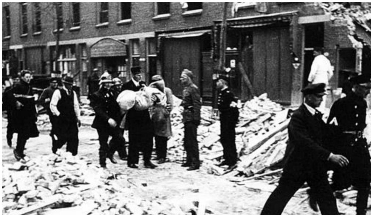
Jan Nieuwelink Kzn. – met witte hemdsmouwen – in het puin van de Zeilmakerstraat/ Blokmakerstraat en omgeving, direct na het bombardement van 1943. Foto: Archief Rotterdam
