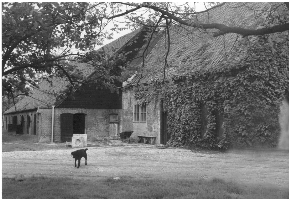
De Reephoeve met op de voorgrond de oorspronkelijke woning.
