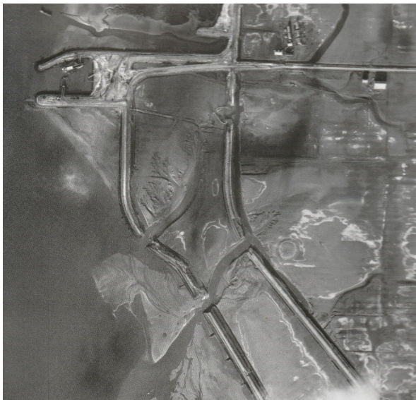
Stroomgaten SP1 en SP2, Willemspolder
